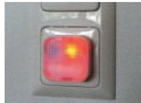
Kontrollieren Sie die einwandfreie Funktion des Netzabkopplers mit einem Steckdosenkontrolllämpchen im Schlafraum. Gute Gerätehersteller liefern dieses gleich mit.
